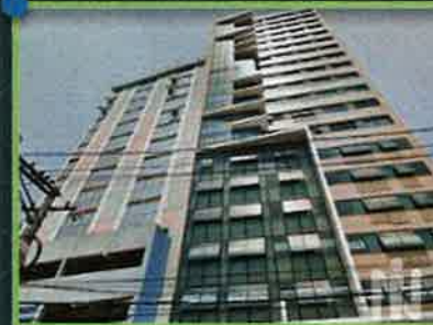
ESCRITÓRIO ADMINISTRATIVO São Gonçalo - RJ
