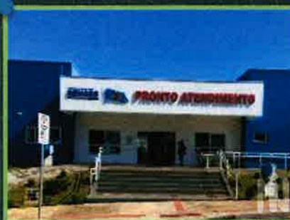
PRONTO SOCORRO MUNICIPAL DE SENGÉS Sengés - PR
